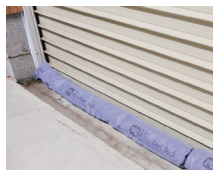
シャッター下からの 雨水の侵入対策
