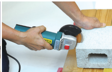
ブロック・レンガの切断
