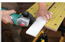
ブロック・レンガの切断
